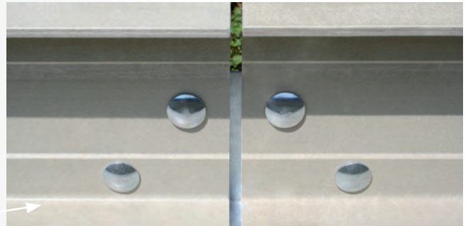
Flachrundkopfschrauben, eingehaltener Ausdehnungsspalt
