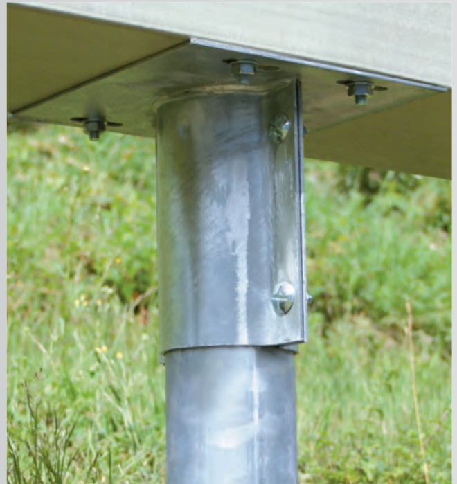
Standard-Kopfplatte in 2 Richtungen verstellbar
